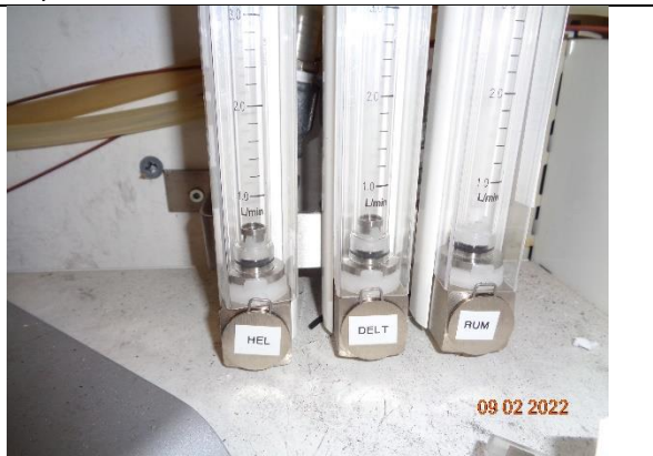
14) Post leak check
